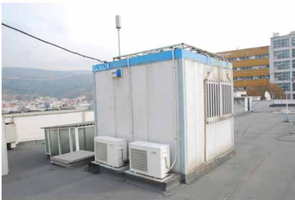
Σταθμός μέτρησης ατμοσφαιρικής ρύπανσης στο ΑΠΘ, Θεσσαλονίκη
